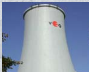
Осень 2004 года, поверхность градирни полностью защищена системой покрытий SikaGard®-680 S серого цвета.
