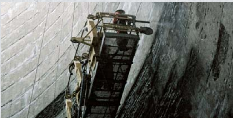
Нанесение торкрета на внутреннюю поверхность градирни в процессе ремонта.
