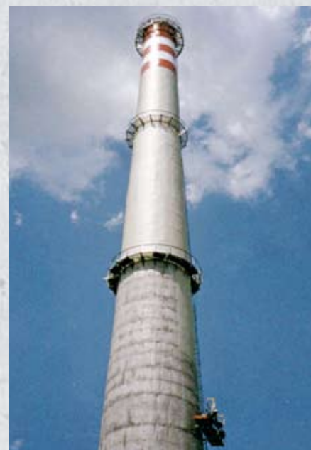
Цветная разметка зон наружной поверхности дымовых труб защитным покрытием SikaGard® 680 S
