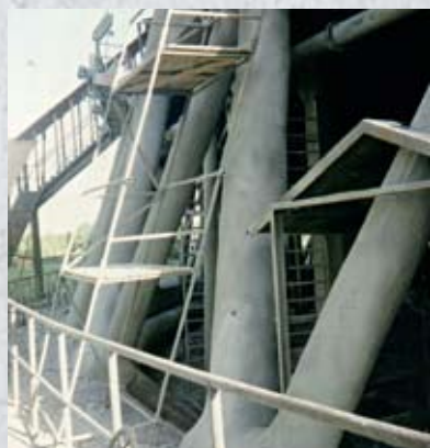
Поддерживающие опоры сложной формы, отремонтированные и усиленные с помощью SikaCem-Gunite 133 .
