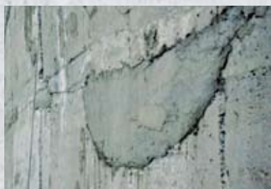
Ремонтный раствор Sika® MonoTop, нанесенный вручную.
