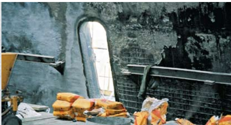
Оборудование SikaAliva для „сухого“ торкретирования в процессе нанесения SikaCem-Gunite 133 внутри градирни.
