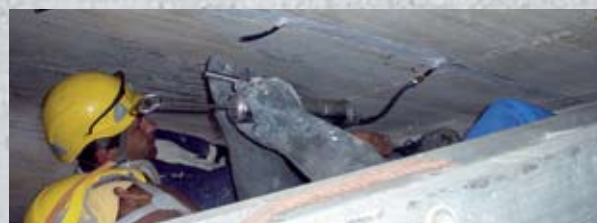
Инъектирование трещин.
