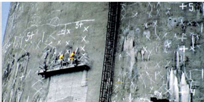
Удаление разрушенного бетона в местах, отмеченных в ходе предварительного обследования.
