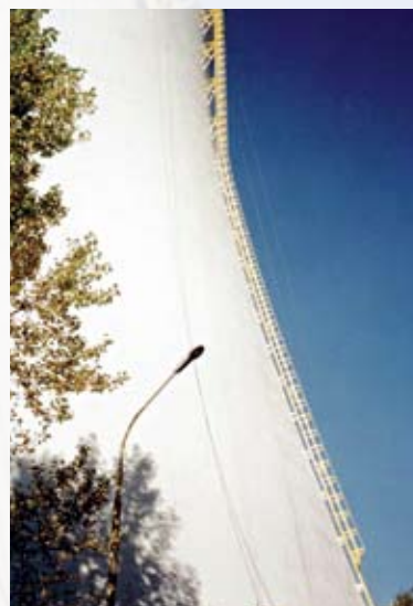
Лестница из оцинкованной стали с защитным покрытием SikaCor® (без грунтовок).
