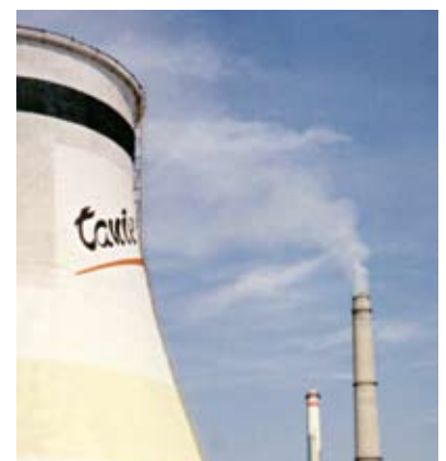
Наружные поверхности подвергаются воздействию дымовых газов от расположенных вблизи дымовых труб.
