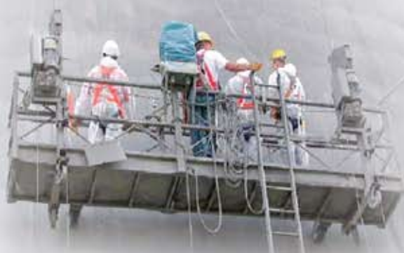
Специалисты по ремонту и защите бетона во время обследования поверхности градирни.
