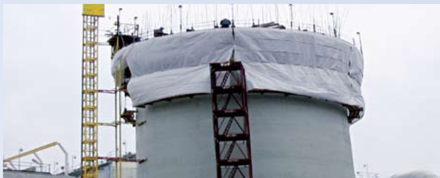
Восстановление и строительство новой дымовой трубы с использованием скользящей опалубки и технологии Sika® ViscoCrete® для производства бетона.
