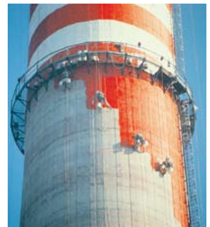
Промышленные альпинисты наносят Sikagard -680 S .
