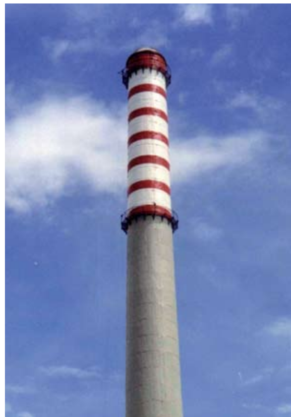
Авиационные предупреждающие цвета финишного покрытия SikaCor EG 5 дымовой трубы в Зоне 1.
