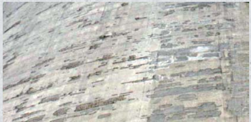
Локальный ремонт наружной поверхности большой градирни, выполненный с помощью сухих смесей для ручного нанесения.
