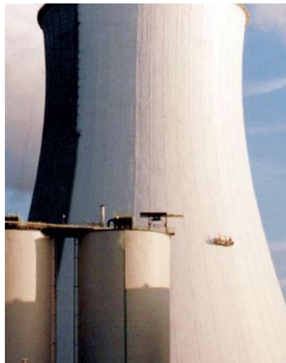
Защитные покрытия Sika® на наружной поверхности градирни (все Зоны).
