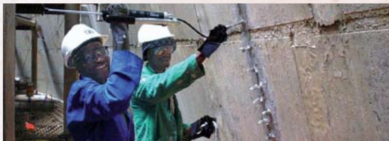
Структурный ремонт трещин с восстановлением несущей способности инъекционными смолами Sika® Injection .
