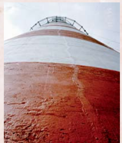
Герметизация трещины герметиком Sikaflex® с последующим нанесением защитного покрытия SikaGard®-680 S .
